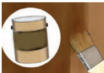
۵- آستر کردن دیوار با آستری (روغن الیف)
