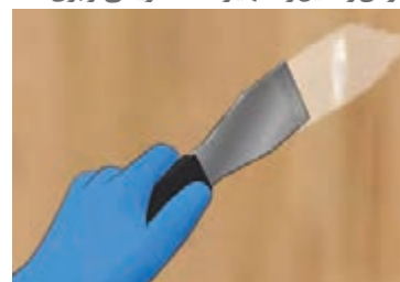
۴- صاف کردن هرگونه ترک از روی دیوار
